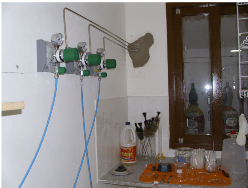
Figura 3.9: Sistema de Gases do LAMOp.
